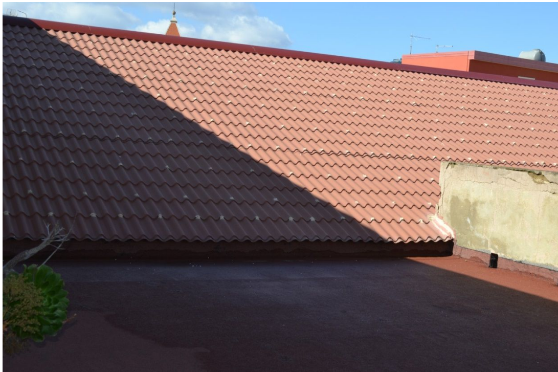
Vista copertura – Vista aere Scuola dell’Infanzia e Primaria “Piria” via Nuarella
